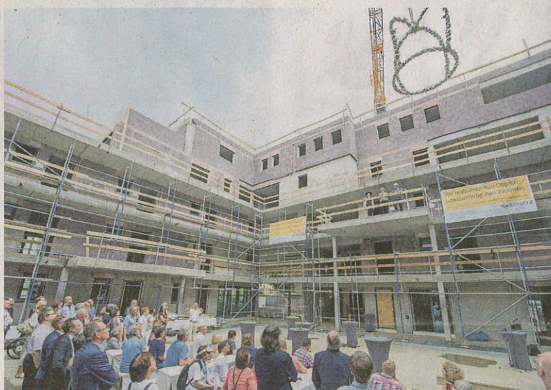
Traditionelles Richtfest nach 42 Wochen Bauzeit an der Hapfelstraße. Anfang 2018 sollen die ersten Bewohner einziehen. Foto: Mario Berger
